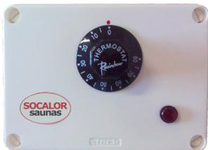
A..Quadro para controle de temperatura comando com Bulbo sensor
